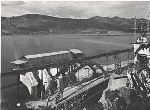
The Malubog dam.
