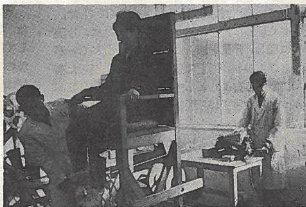
第2図 慣性エルゴメーターで脚のパワーを測定する装置(東京大学体育研究室1962)
