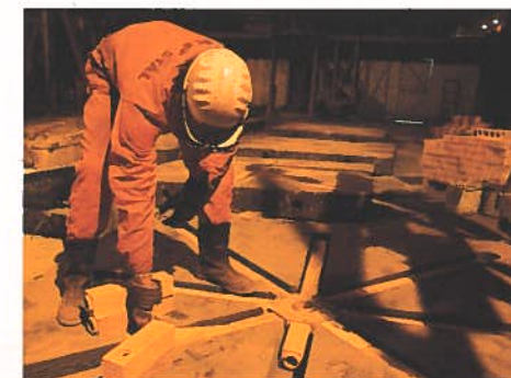
Stigplansberedning är ett förberedande arbete inför gjutningen i ett stålverk. Ihåliga tegelstenar läggs i en form och under arbetet utsätts operatören bl a för kraftig värme från formarna och obekväma arbetsställningar. I ett projekt, som leds av professor Ulf Åberg, STU, söker man komma tillrätta med stig-
