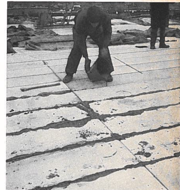
Bild 1. Fogning av lättbetongplank med hjälp av hink.
