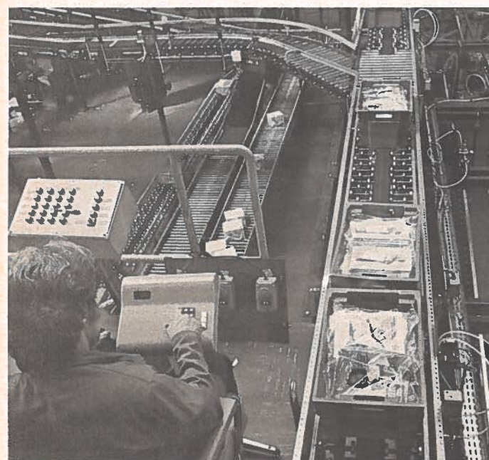
Figure 13: A son entrée dans le système de répartition, chaque bac contenant des appoints reçoit un signal numérique d'indexation qui le dirige vers l'un des postes de triage par client.
