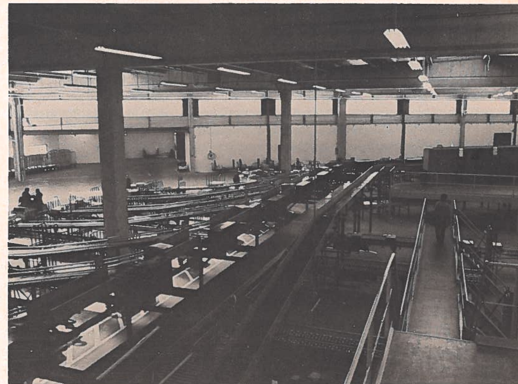
Figure 15: Système de convoyeurs dans la zone de triage final avec goulottes de sortie (à gauche).
