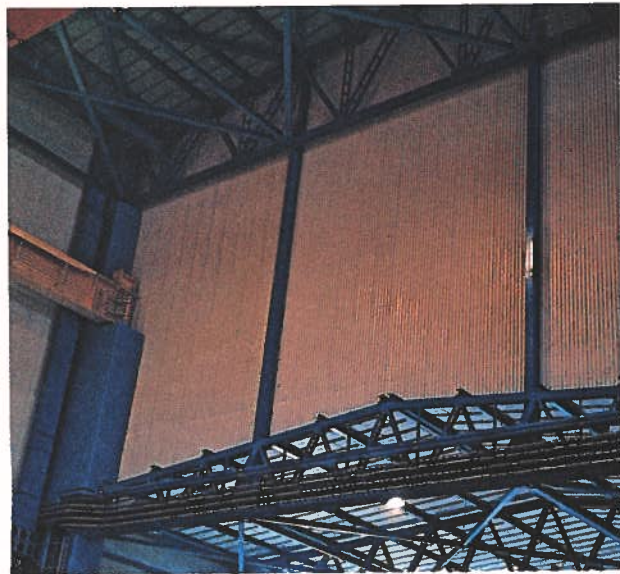
Bilden visar en arbetslokal där ljusarmaturerna är placerade på ca 10 m avstånd från vägg. Belysningsstyrkan en meter över golvytan är ca 500 lux.
