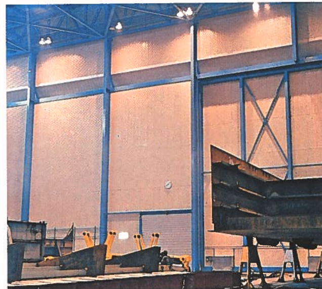
En annan verkstadslokal där belysningen också utgöres av högtrycksnatriumlampor som i arbetsplanet ger belysningsstyrkan 500 lux. I denna lokal är ljusarmaturerna i tak placerade nära väggarna, vilket gör att väggarna blir belysta och rummet upplevs ljusare än på föregående bild.
