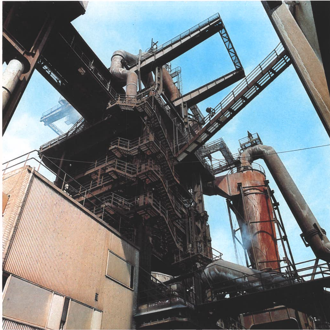
Lors de la construction de la nouvelle aciérie, la capacité du haut-fourneau sera portée à 350.000 tonnes par an.
