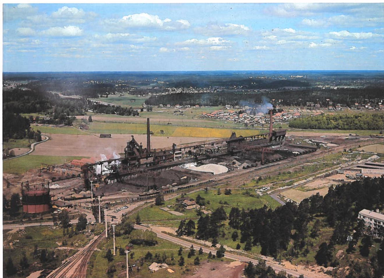
Vue générale de l'usine de Turku. Le port est tout près de l'usine. La capacité annuelle de l'usine est d'environ 200.000 tonnes de fonte. La coulée se fait à des intervalles de trois heures dans des poches de 40 tonnes (à droite).
