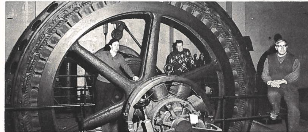
Vanha generaattori on edelleen talalla voimalaitoksen alakerrassa. Etualalla generaattorin ns. herätinkone, joka antaa tasavirtaa generaattoripyörän magneetteihin.
