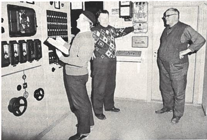
Tällä laitteella säädetään turbiinin tehoa sekä tahdistetaan kierroslukua ja kuormitusta.
