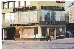
Closest to the Hospiz NMKY: KOP, Kaisaniemenkatu 10.
